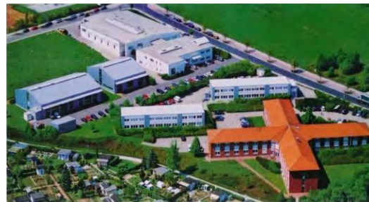
Technologiepark Leipziger Straße 27 Mittweida
